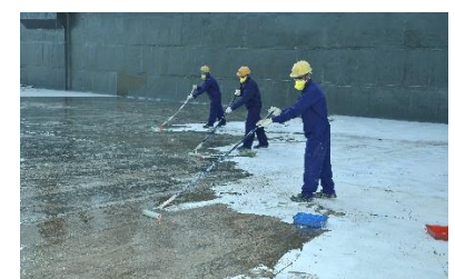
Application of primer – Nitoprime 30
